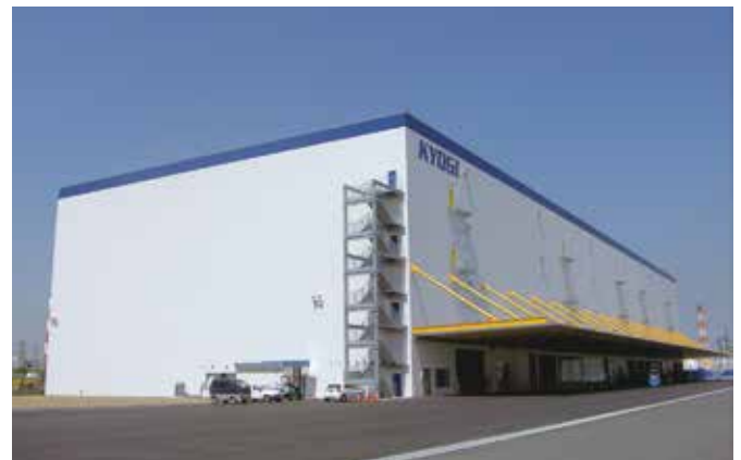
倉庫(外壁ワイドパネル・間仕切)
