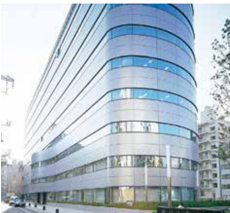
オフィスビル (外壁)
