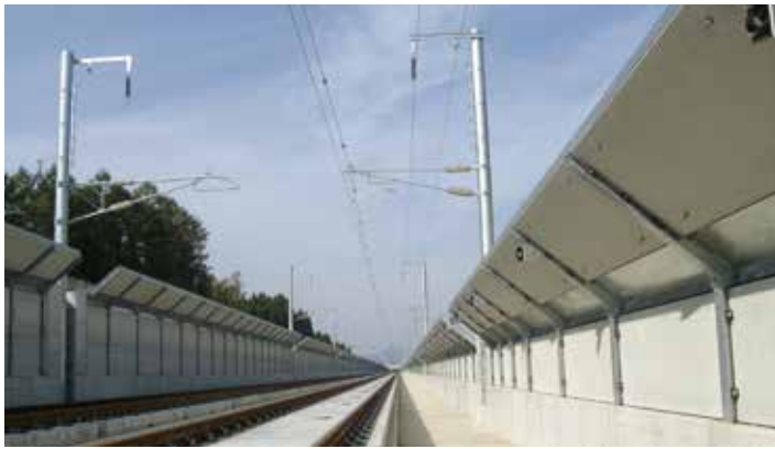
鉄道(防音壁 半雪覆タイプ)
