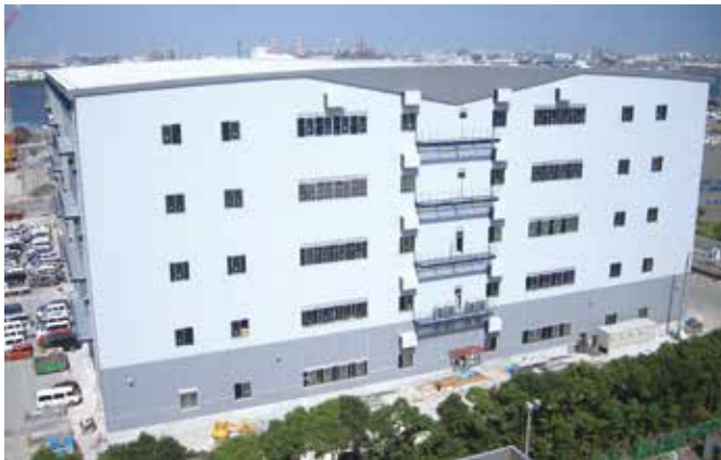
倉庫(外壁ワイドパネル)
