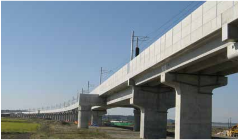
鉄道(防音壁 直壁タイプ)
