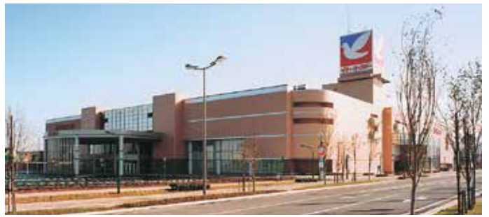
商業店舗ビル(リップ付外壁)
