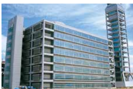
空港施設 (外壁・間仕切)
