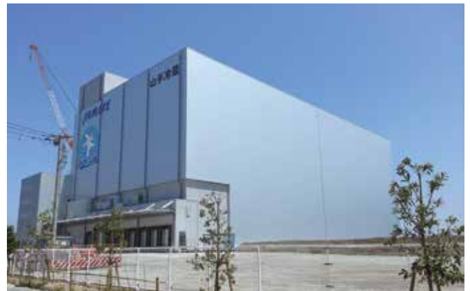
免震冷蔵庫(外壁)
