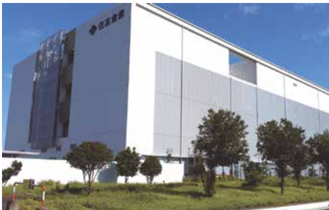
倉庫(リブ付外壁)
