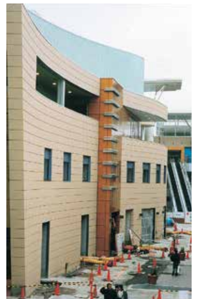
商業店舗ビル(化粧目地付外壁)
