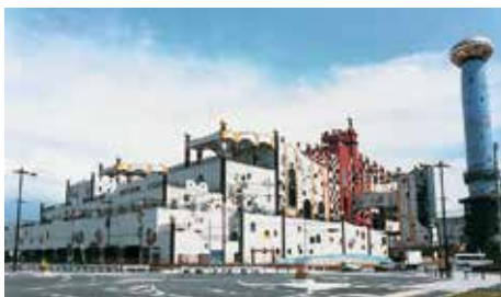
清掃工場(セラミックス吸音材一体壁パネル)
