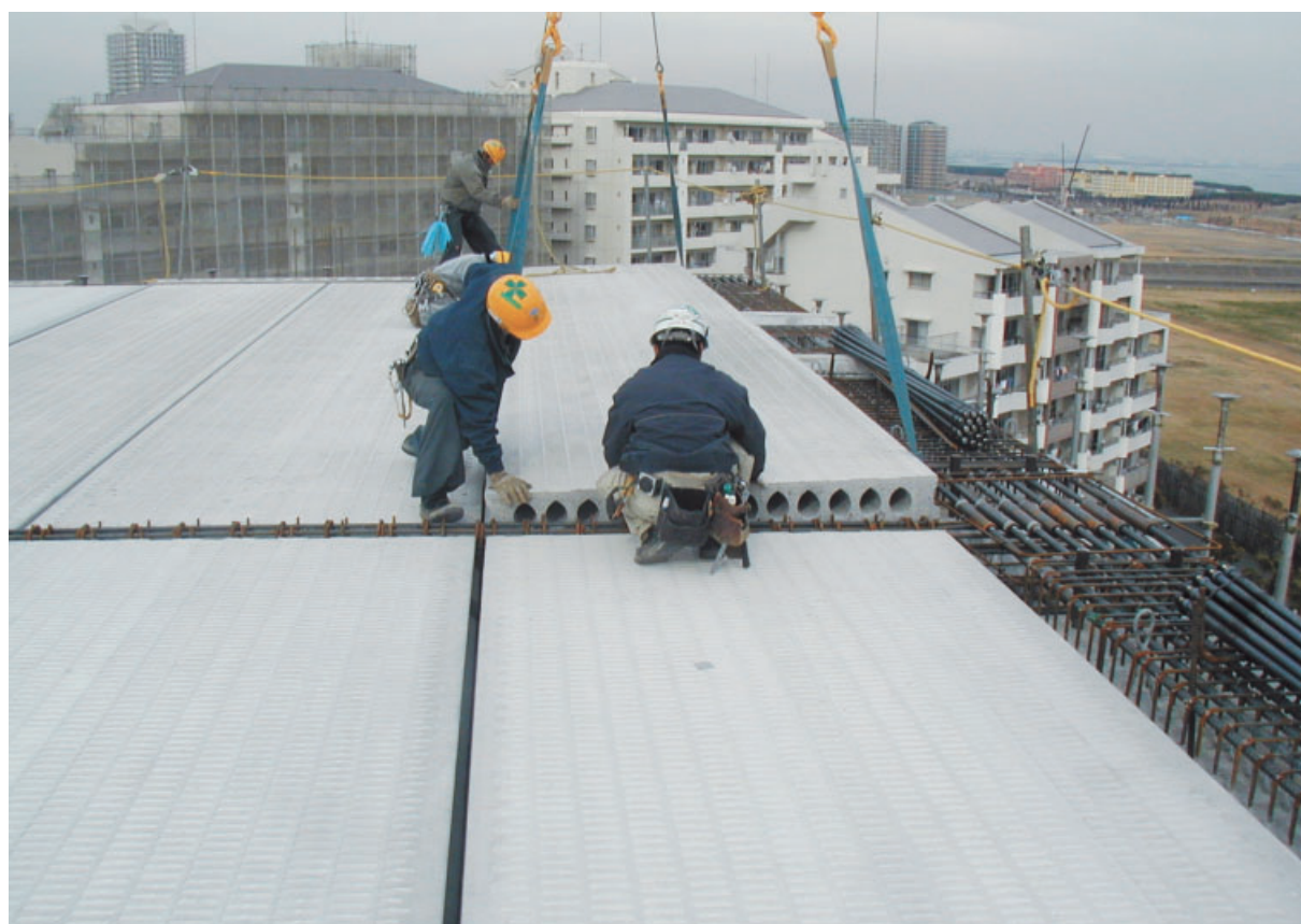
高層マンションの床に用いられた新製品 幅広板の敷き込み
