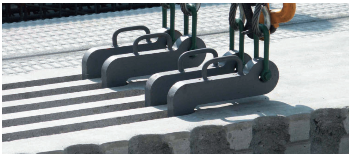
写真上 Jスラブパネル敷き込み中 写真下 Jスラブスリット加工及び吊上げ金具
