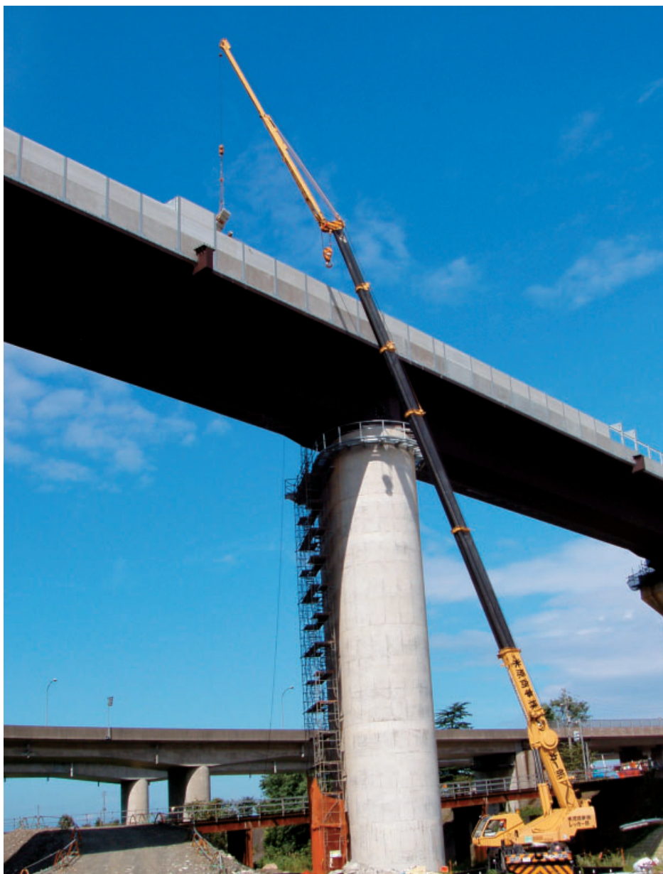
北陸新幹線防音壁工事 新潟県糸魚川 北陸道架道橋付近
