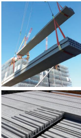
グランドプリンスホテル赤坂跡地に建設中の一大プロジェクト。オフィス・ホテル棟では、将来開口可能床として、各階設置部にフルPC床材を使用し、富士山が一望出来る住宅棟には、ハーフPC合成床板が各階に採用されています。
