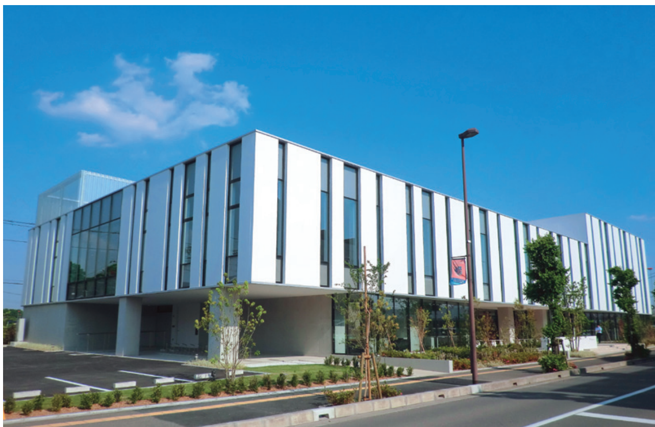
埼玉県看護協会新研修センター(外壁)
