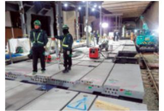
銀座線渋谷駅では線路切替及びホーム移設の大規模工事を年末年始に電車を止めて実施しました。工事終了後より新しいホームの運用が開始となり、新しいホームは幅が約6mから約12mに拡幅し、ホームの全面にスパンクリートの床板が採用されました。ホーム線路側にはホームドア対応パネルのMスラブを使用しました。
