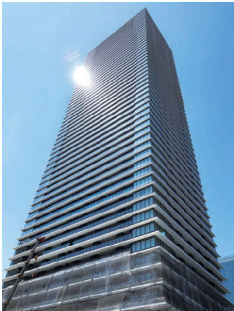
〈マンション〉合成床 港区の54階建てタワーマンション 各階に250mm厚の合成床が採用されました
