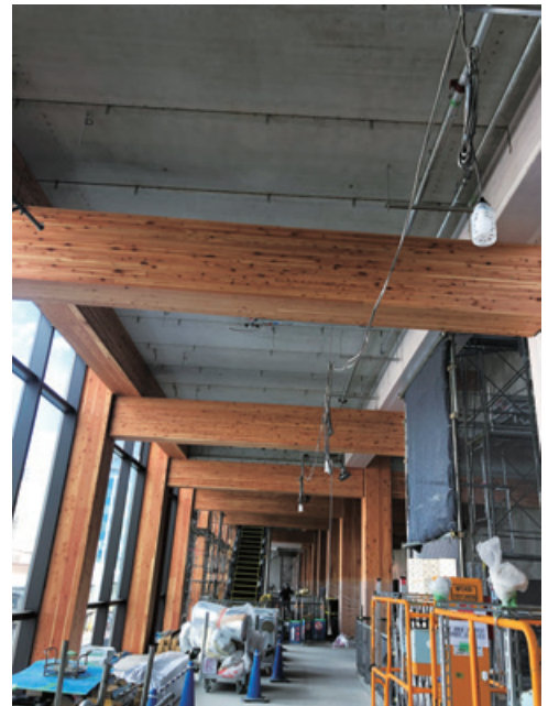
〈庁舎〉合成床 木造構造物とコンクリート合成床の融合です ぬくもりが感じられる仕上がりとなりました
