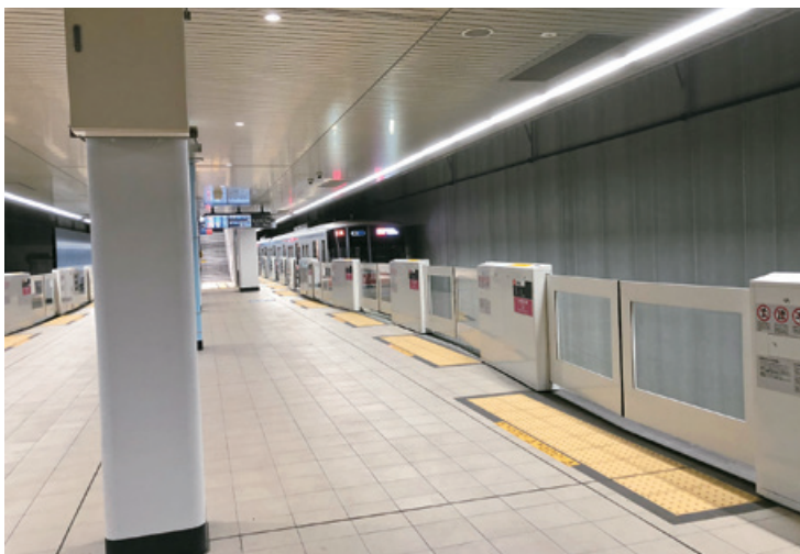
〈鉄道駅〉 従来のホーム床に加え、線路に接する化粧壁が新駅に初めて採用されました
