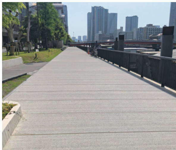
〈運河遊歩道〉 水辺での耐久性、防滑性が認められ幅員5mの遊歩道に採用されました
