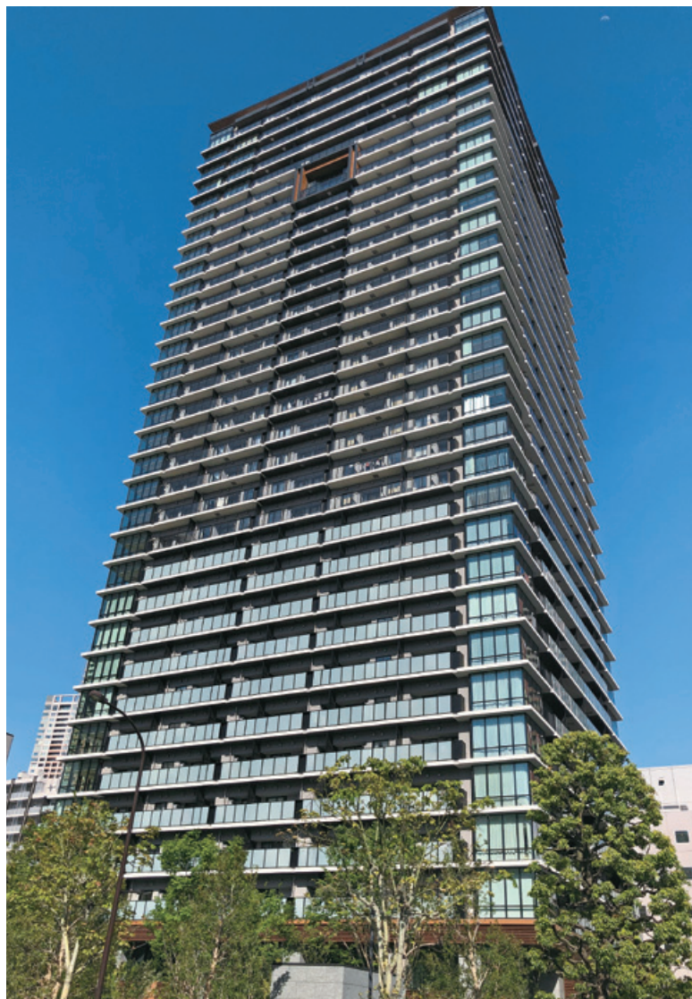
〈タワーマンション〉 板長8m×厚さ200mmという長スパンの床板により工期の短縮に貢献いたしました
