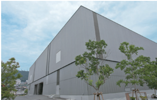
〈コンベンションセンター〉 板長12mの長尺パネルが外壁に採用されました
