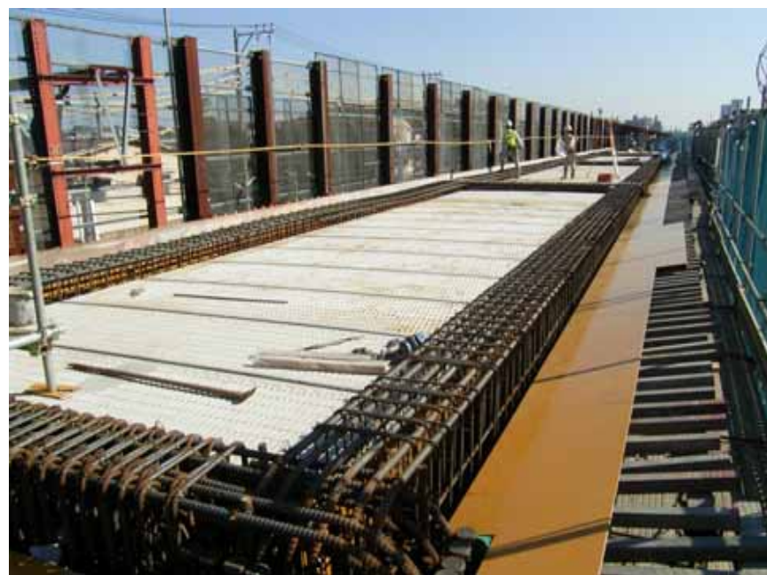
中央線高架(三鷹～立川間)
