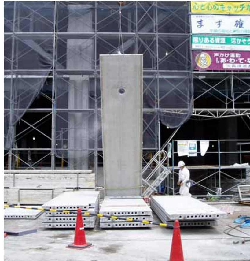
壁板の施工
