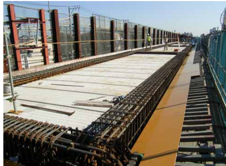
中央線高架(三鷹～立川間)
