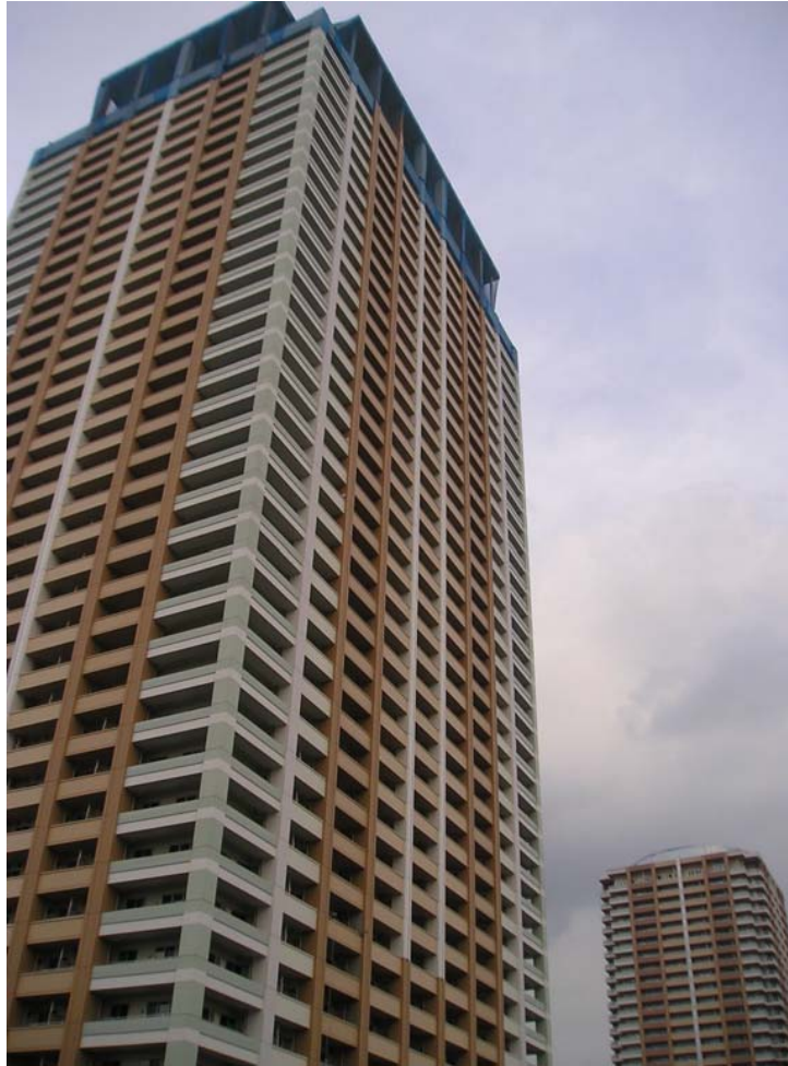
市川駅南口地区第一種再開発事業A・B街区
