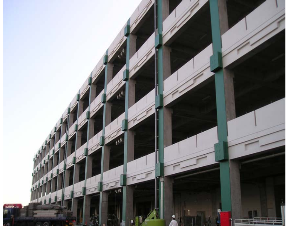
川崎水江町物流倉庫新築工事
