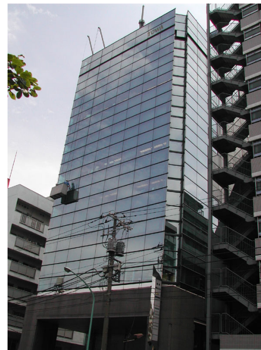
文京区 駒込スパンクリートビル
