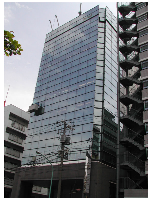
文京区 駒込スパンクリートビル
