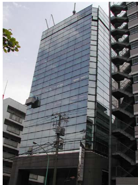
文京区 駒込スパンクリートビル
